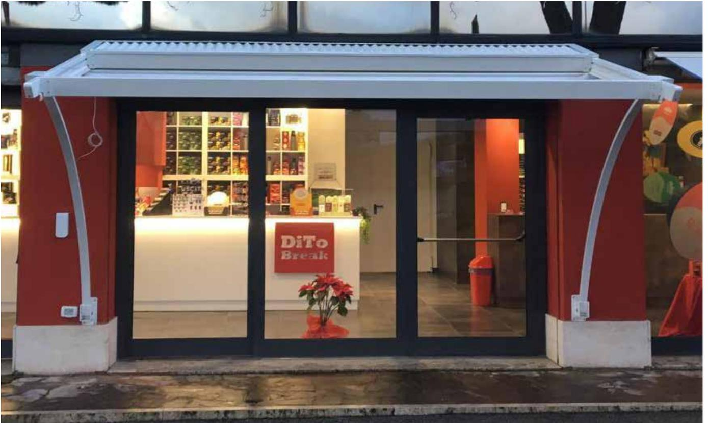
La E95 Arco, è una pergola dal design ultramoderno realizzata interamente in alluminio, movimentata da un motore elettronico radiocomandato, che permette l'apertura a impacchettamento del telo fino alla massima tensione. La pergola non ingombra lo spazio sottostante grazie agli archi ancorati a parete.
