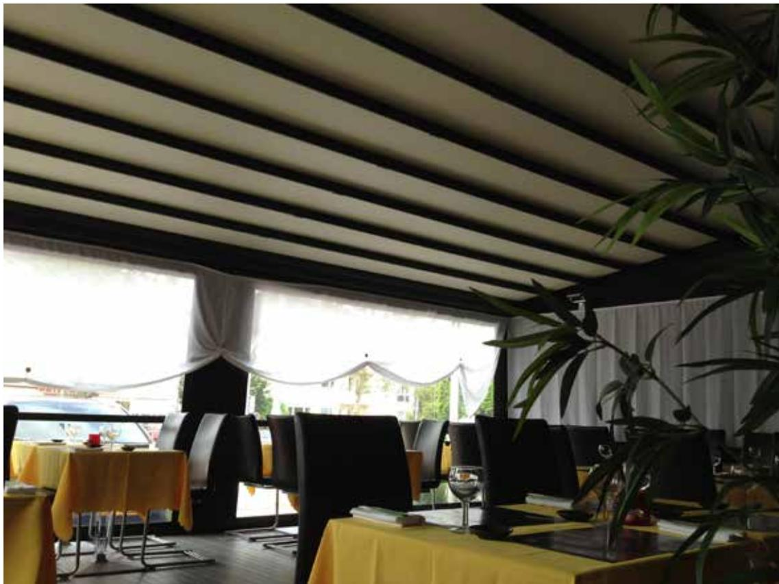
Struttura dal design moderno e lineare, interamente realizzata con profili in alluminio verniciato e con coperture in PVC oscurante pretensionato, o in PVC Valmex oscurante goffrato oppure in PVC Opatex bicolore, la struttura è addossata e movimentata da un motore elettronico radiocomandato, che permette l'apertura a impacchettamento del telo, fino alla massima tensione.
