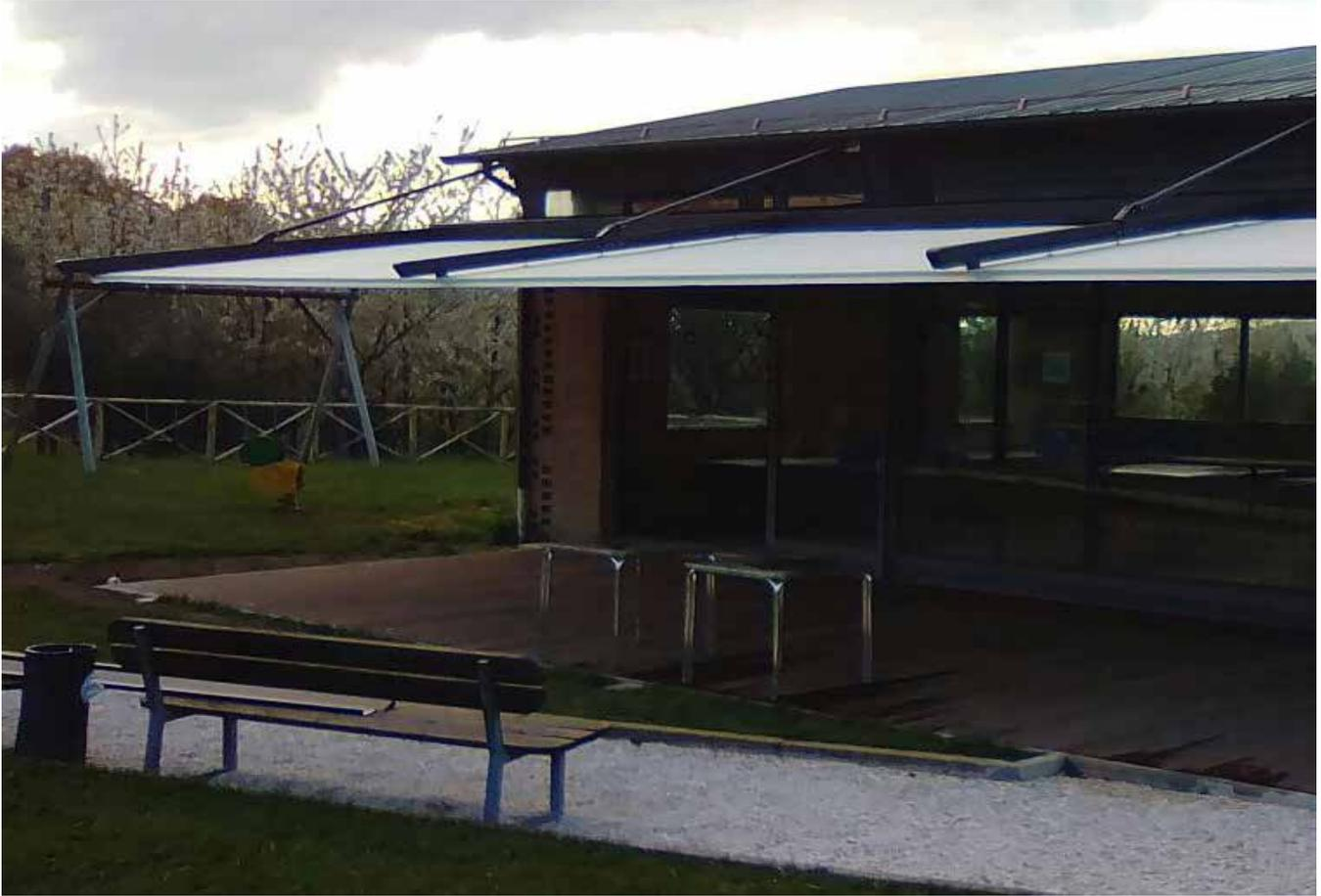
E' una struttura pensile elegante e moderna, progettata per coprire gli spazi sottostanti, senza avere l'ingombro delle gambe sul pavimento. La struttura è costituita da due guide laterali all'interno delle quali scorrono i profili portatessuto, sorrette da due staffe rigide che le fissano alla parete di ancoraggio. Si raccomanda un attento collaudo della parete per verificare l'idoneità al fissaggio della struttura.
